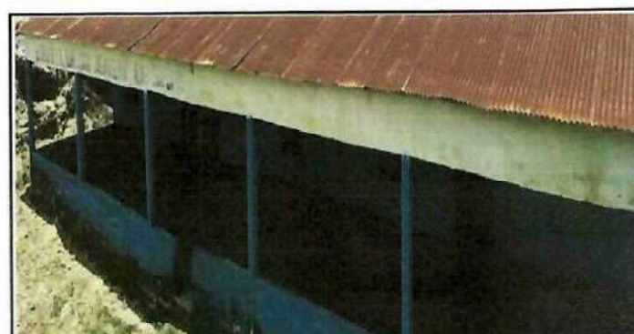
Foto 6: Instalacion de Balcones en el corredor.
