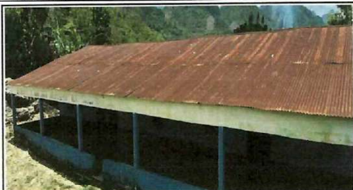
Foto 1: Sustitucion de cubierto de lamina.
