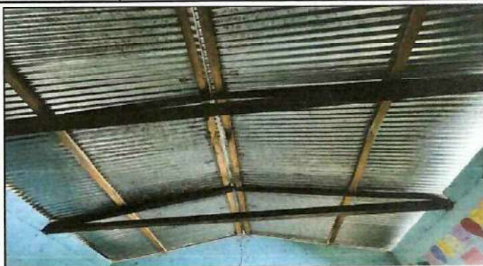
Sustitucion de estructuras metalicas.
