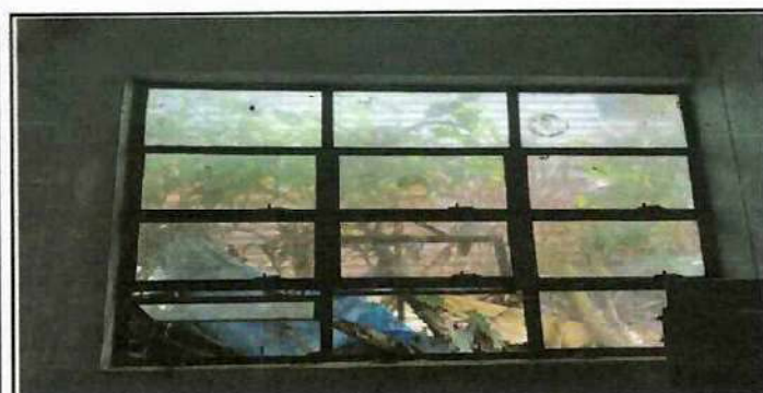
Foto 5: Instalacion de Balcones de metal.
