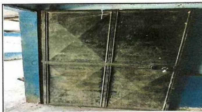
Foto 4: Mantenimiento de puertas.
