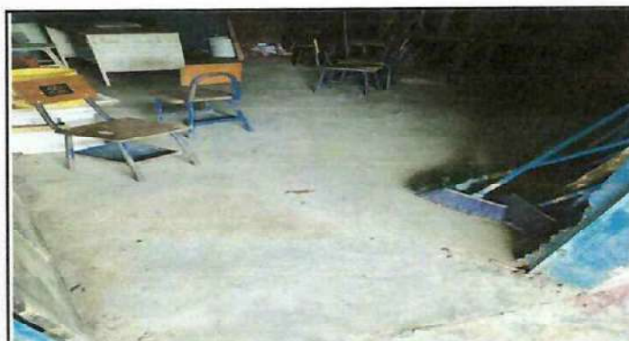
Foto 3: Instalacion de piso ceramico.
